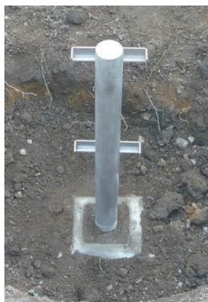
フェンス基礎ブロックの中にコンクリートを流し込み、支柱が沈み込まない程度に固まったら支え棒を外し、養生後に仮埋め戻しを行う。
