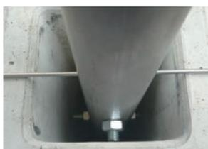
フェンス基礎ブロックを地中に水平に設置して周囲にコンクリートを流し込み、養生後に全ねじ棒・ナット・支え棒で支柱を仮固定する。
