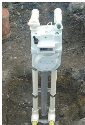
コンクリートが完全に固まってから配管を接続し吊りバンドで支柱と配管を固定する。
