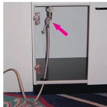
ガス栓の設置が難しい場合でもガスコンセントを設置(増設)することができます。
