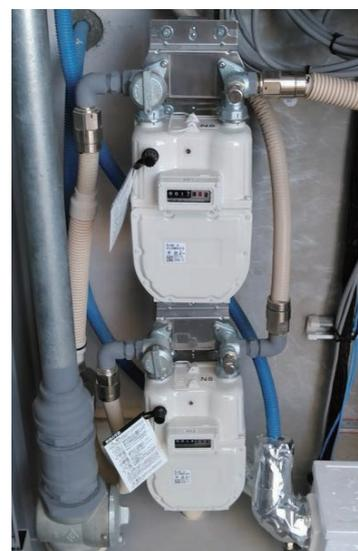
2台設置の施工例
